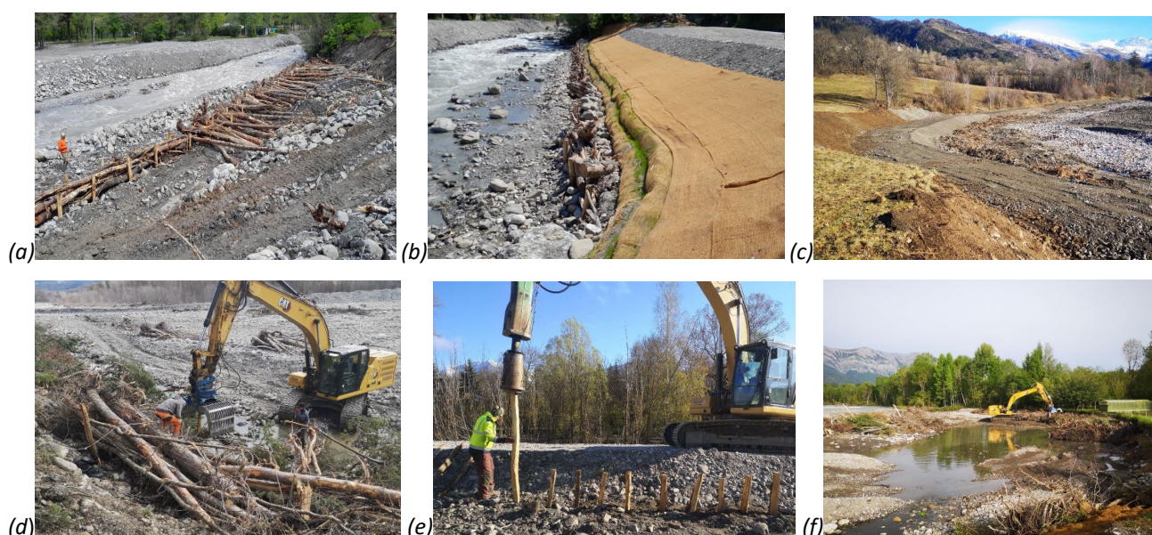
Figure 1. Sur le Chagne (a, b) et sur le Drac (c)-(f) la nécessité de traiter les embâcles de bois a été convertie en opportunité en les intégrant dans les ouvrages de protection des berges. (photos: CCGQ, CLEDA).
