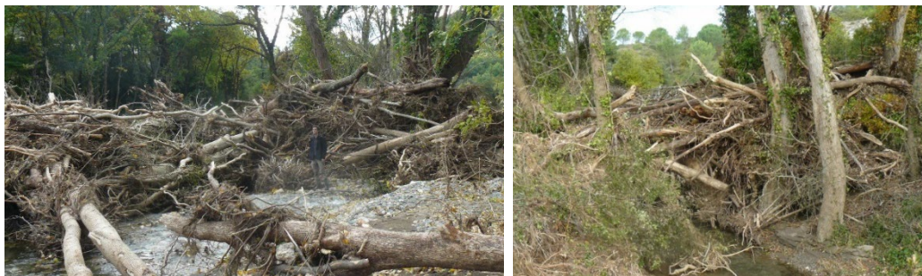
Figure 2 : Photos d'accumulations massives de bois flottant contre des arbres ayant résisté (Source : SMAC)
