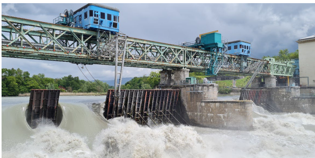
Abattage des Hausses à Seyssel (France) – Opérations de mai 2021 (photo CNR)
