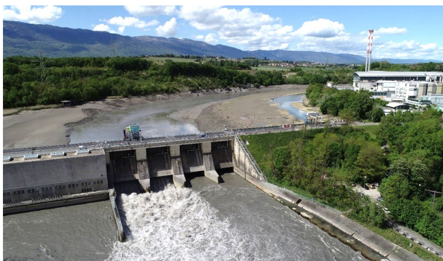
Barrage de Verbois (Suisse) - Abaissement partiel de la retenue en mai 2021 (photo SIG)
