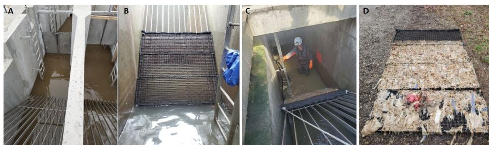
Figure 1. Dispositif de récupération des déchets des réseaux d'assainissement (Photos : G. Bretin, G. Darmon) : A) Configuration en 2 travées, B) Caillebotis munis de filets, C) Redirection du flux après installation des caillebotis, D) Macro-déchets récupérés en 25 minutes.
